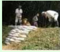
漏水箇所の補修
