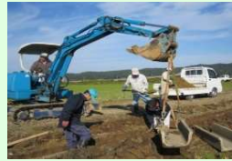
コンクリート水路の更新
