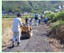
未舗装農道の舗装
