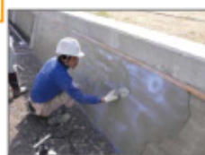
水路の補修・更新
