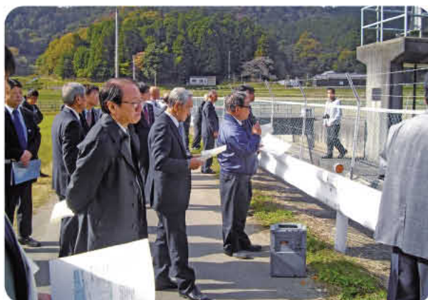
水土里ネット加古川西部 東西分水工
