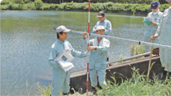
堤体測定①
