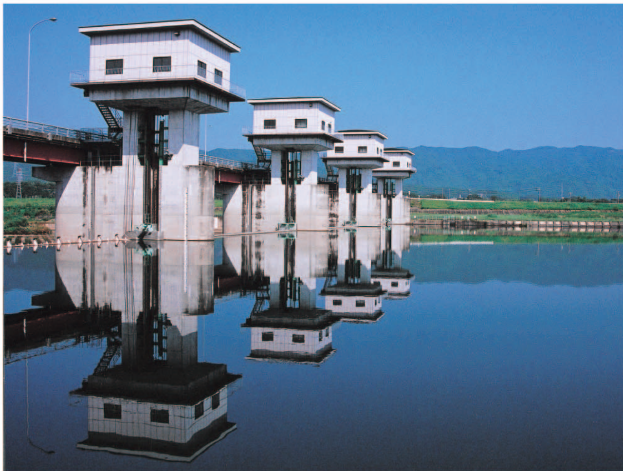
牟呂・松原頭首工(新城市)
