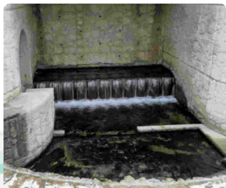
慶座ダムの水位水質観測施設
