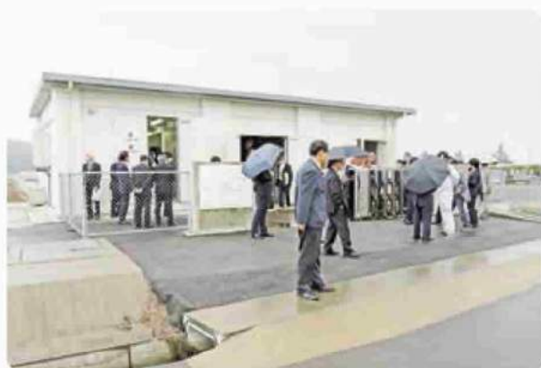
ニタ口小水力発電所
