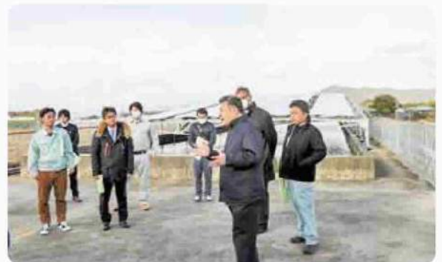
栄斧取(さかえおのとり)揚水機場での現地研修
