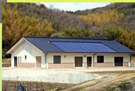
集落排水処理施設の屋根を利用した事例 〔岡山県 備前市〕
