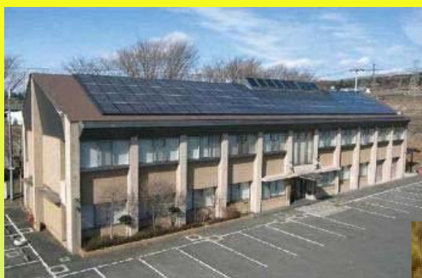
改良区の屋根を利用した事例 〔群馬県 渋川市〕
