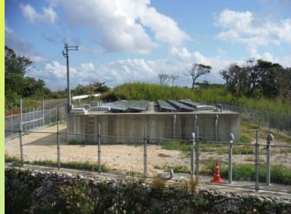
吐水槽の上部を利用した事例 〔岡山県 備前市〕
