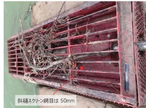
斜樋スクリーン(網目 t=50mm)
