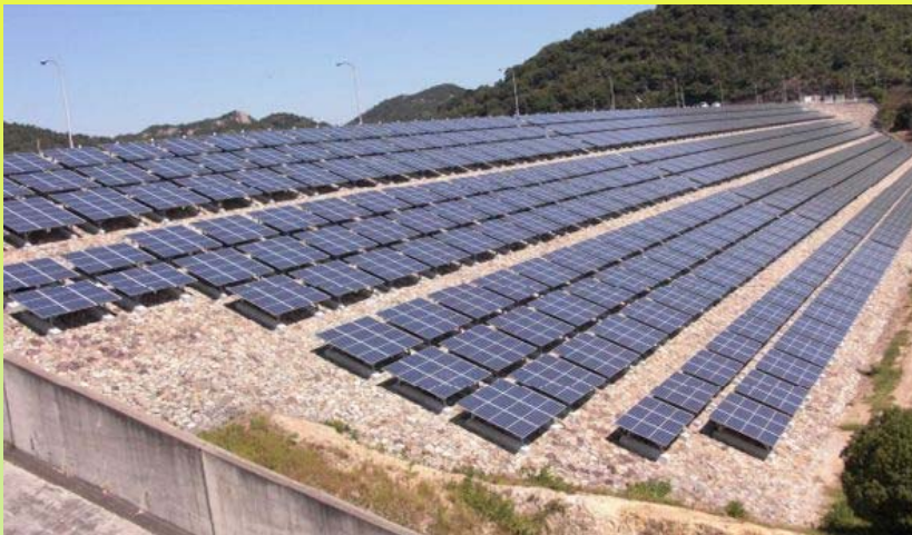
法面を利用した事例 〔兵庫県 加古川市〕
